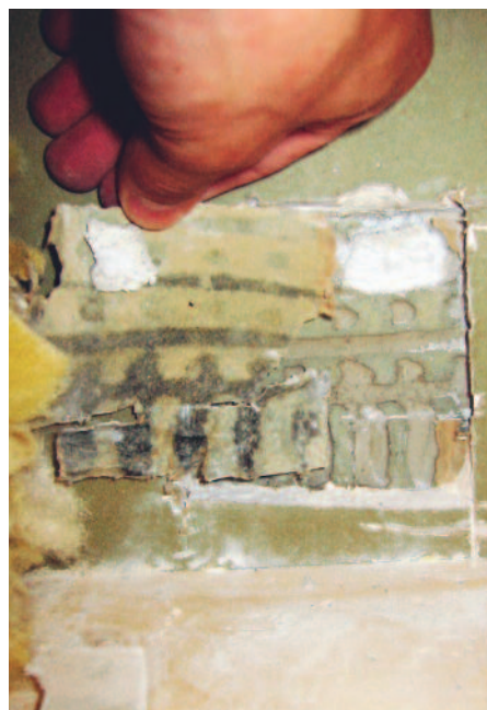
Bild 1: Skadad kartonggips.
