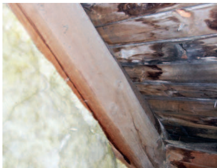
Fuktskador och träskyddsbehandlat trä bakom kontorsväggarna.
